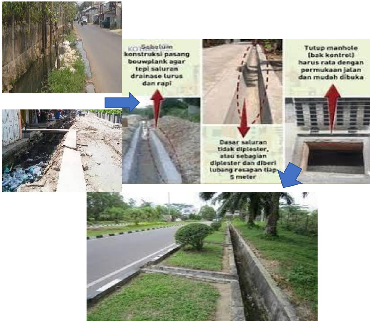
Gambar 10. Pemenuhan standart pemelihaaraan Drainase / saluran Tepi Jalan
